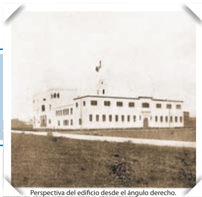
Perspectiva del edificio desde el ángulo derecho.
